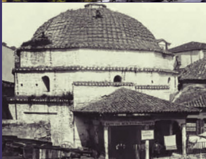
Εικ. 2. Μπέη χαμάμ. Γενική άποψη (Πηγή: Παϊσίδου, χωρίς έτος έκδοσης)
