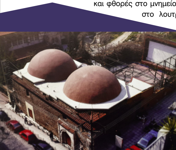
Εικ. 9. Γενί χαμάμ (Πηγή: Παϊσίδου χωρίς έτος έκδοσης)
