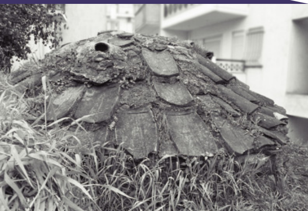
Εικ. 11. Οθωμανικό λουτρό επί της οδού Γλαύκου. Ο θόλος του θερμού χώρου από δυτικά (Πηγή: Ανδρούδης 2010)
