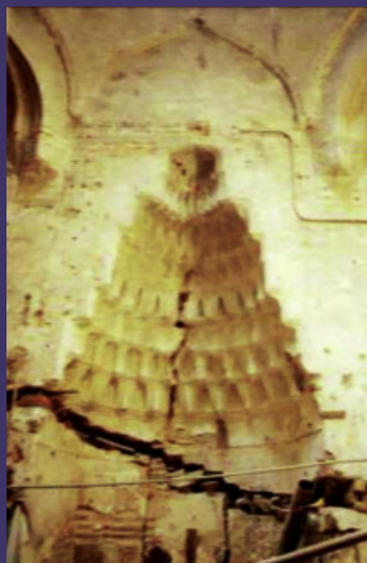
Εικ. 8. Γιαχουντί χαμάμ. Η κόγχη τύπου μιχράμπ στο ανδρικό τμήμα. (Πηγή: Κανετάκη 2004)
