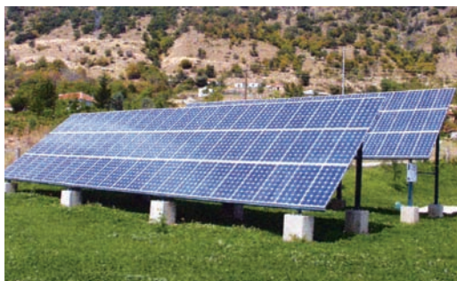
Εικόνα 5. Ηλιακοί συλλέκτες εξασφαλίζουν τις μεγαλύτερες ανάγκες σε ηλεκτρική
