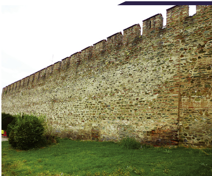
Εικ. 3. Επαλληλία οικοδομικών φάσεων, όπως αποτυπώνεται στην τοιχοποιία του ανατολικού τείχους (Αρχειό ΕΦΑΠΟΘ).
