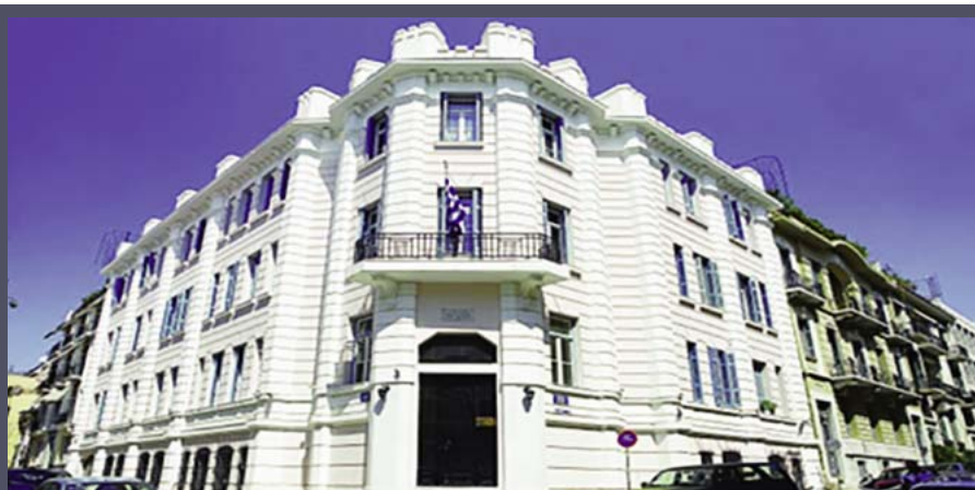
Εικόνα 2: Κτίριο ΔΙΣ, έδρα της Γαλλικής Αποστολής και της Προπαρασκευαστικής Σχολής Επιτελών
