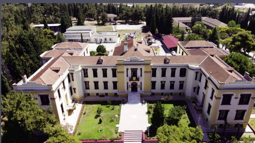
Εικόνα 6. Οι εγκαταστάσεις της ΑΔΙΣΠΟ
